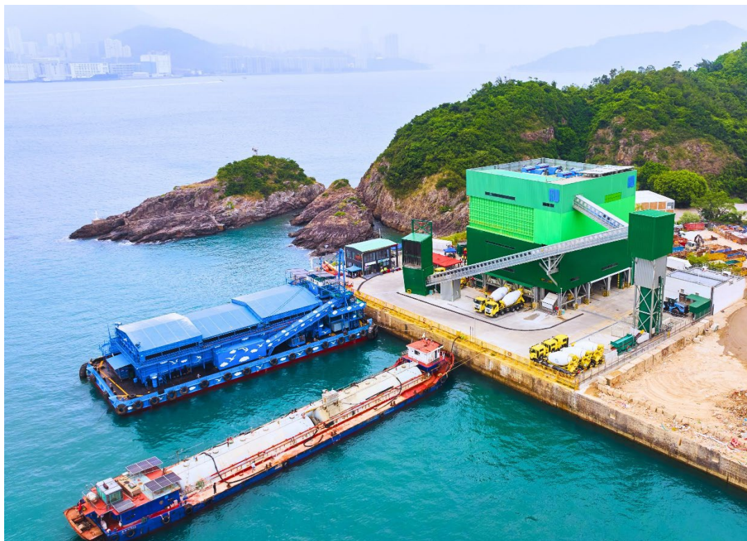
將軍澳137區混凝土廠
