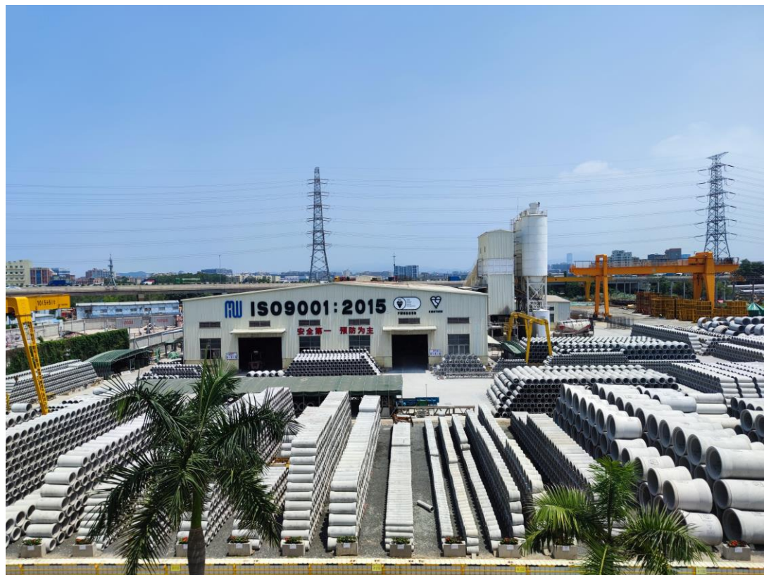
深圳沙井混凝土預製件廠
