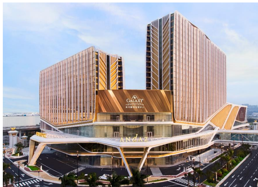
银河国际会议中心、银河综艺馆及安达仕酒店大楼的最新照片
