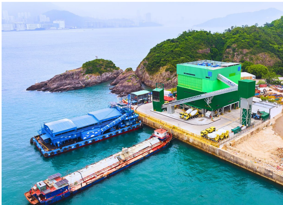
將軍澳137區混凝土廠
