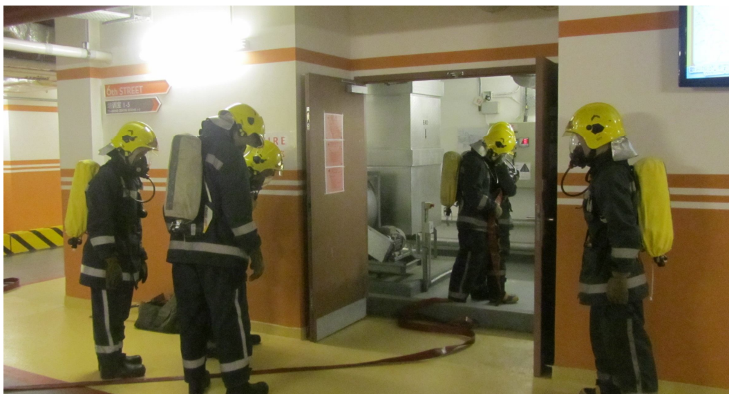
P004：消防人员去到模拟发生火警的地库鲜风扇房检查。
